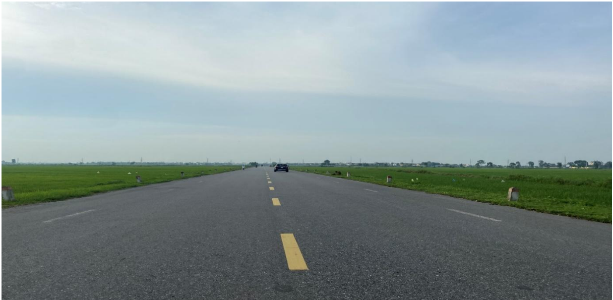
Hiện trạng đường tỉnh 276 mới
